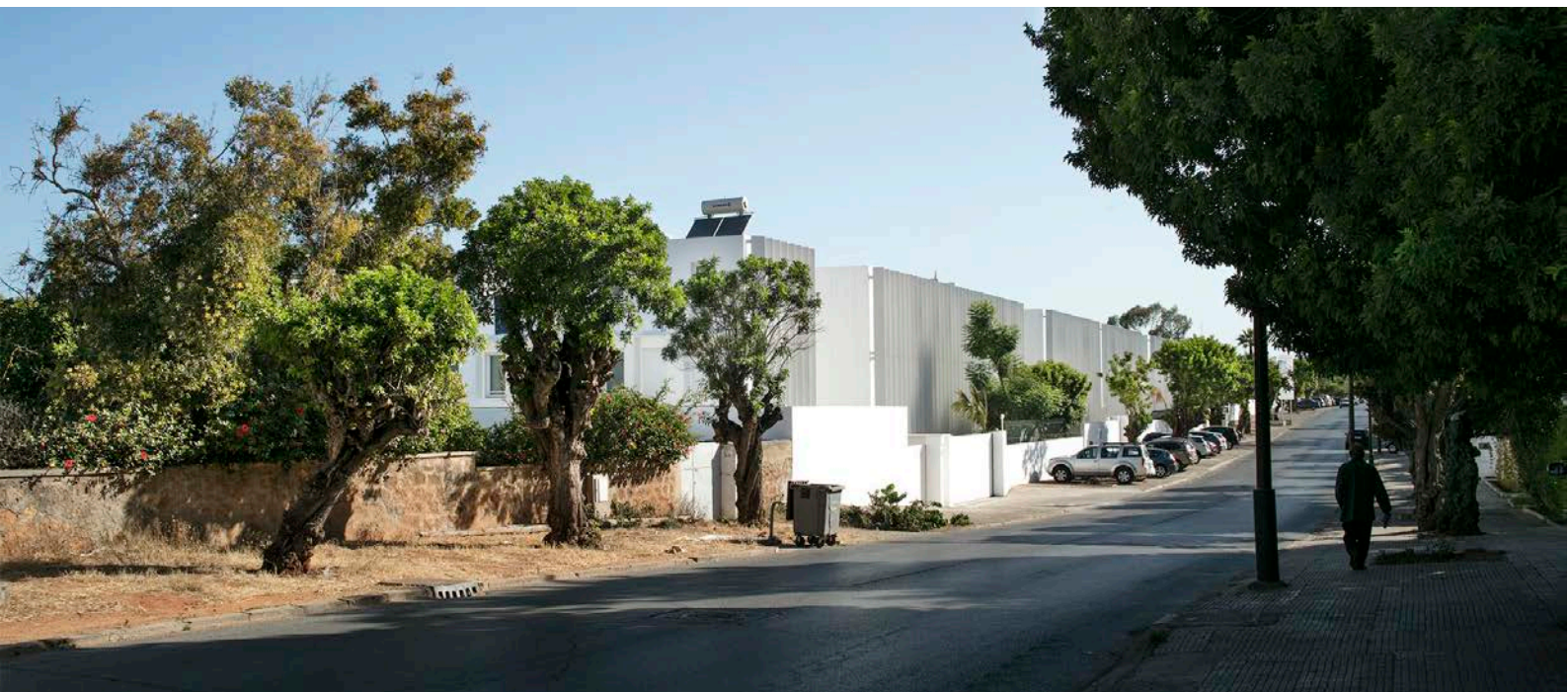
10 - Depuis l'espace public, les bâtiments restent assez opaques pour des raisons de sécurité. photo ©Edouard Decam
