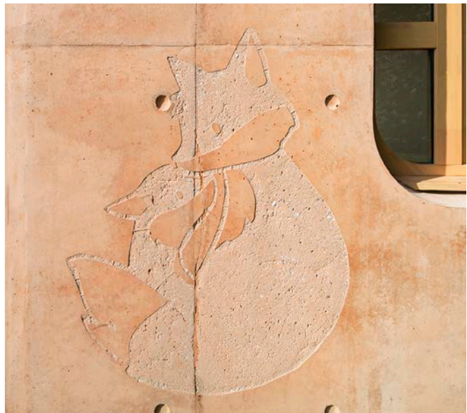
05 - L'univers de la signalétique s'intègre en finesse au projet, avec des bétons sablés au pochoir sur les façades extérieures. photo ©Edouard Decam
