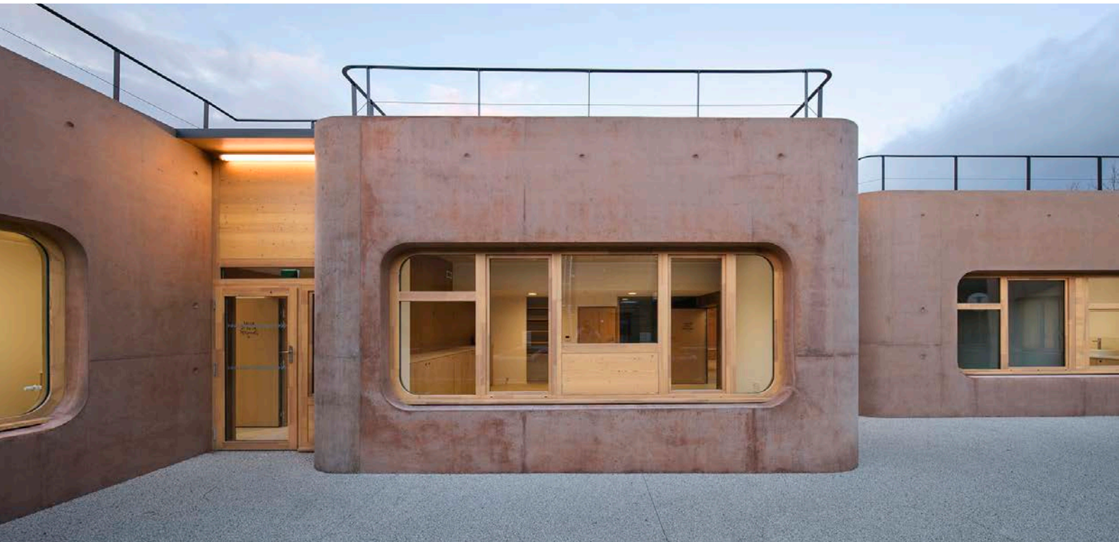
04 - Le rapport avec l'extérieur a été pensé dans le détail des menuiseries et par le jeu des volumes, des pleins et des vides. photo ©Edouard Decam
