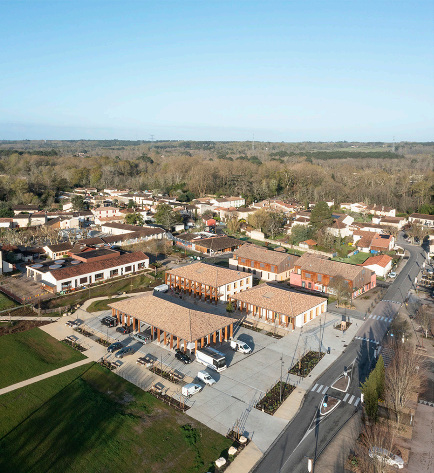
03 - Le projet s'inscrit dans la topographie existante afin de créer des continuités urbaines et paysagères avec les espaces publics adjacents. photo ©Édouard Decam
