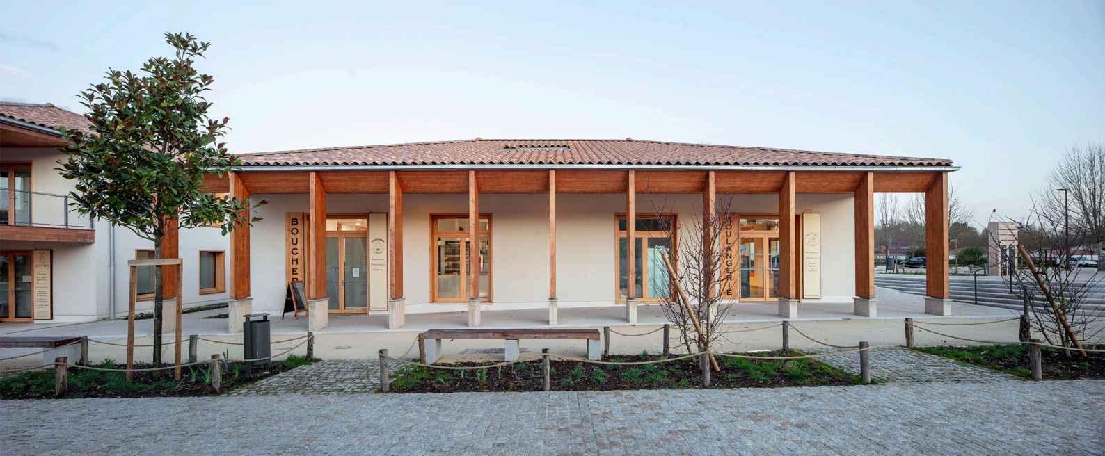
09 - Quatre commerces de proximité animent le rez-de-chaussée des deux bâtiments : une boulangerie, une boucherie, un caviste, un primeur et le cabinet médical. photo ©Édouard Decam
