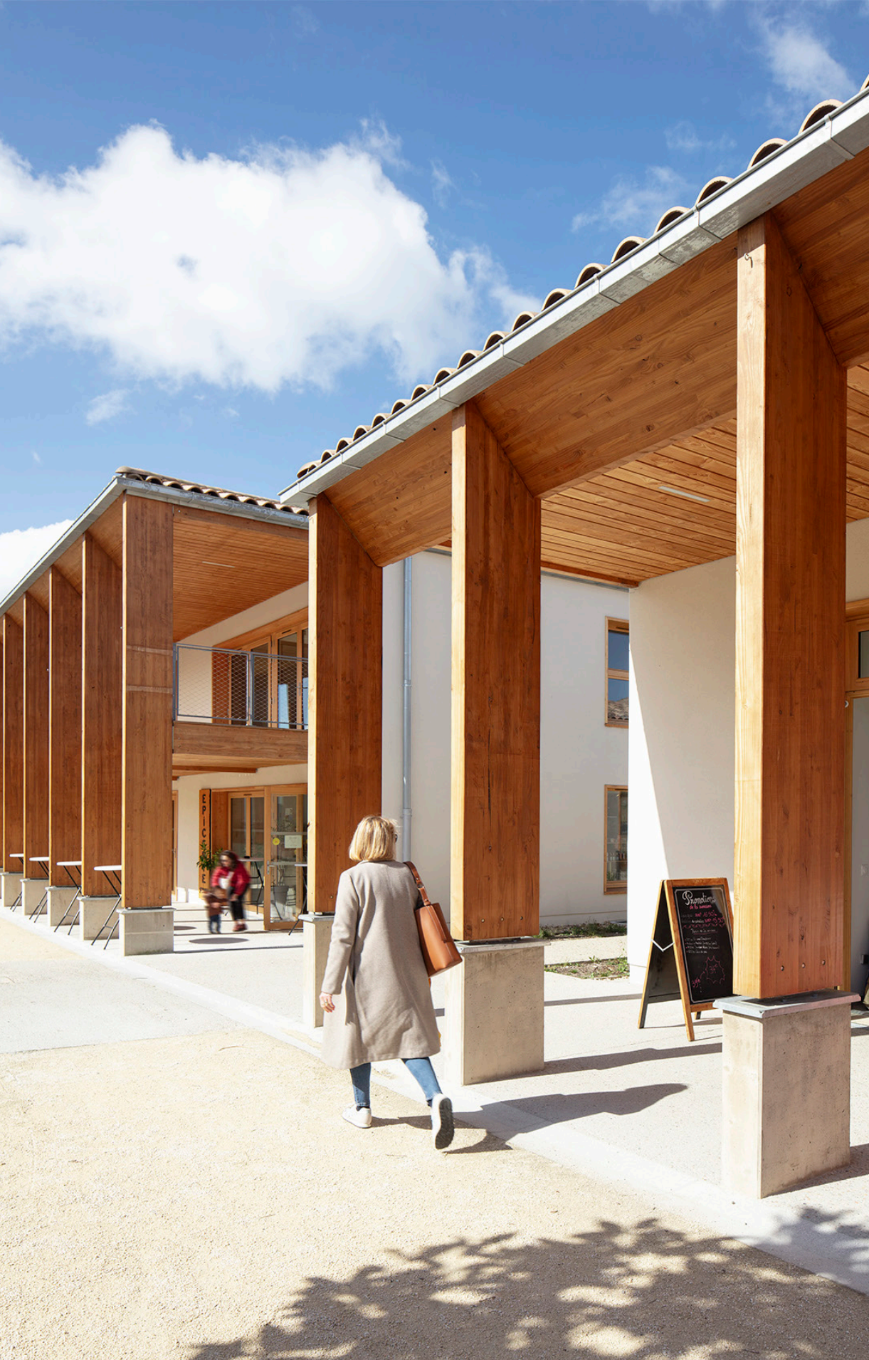
04 - Les choix constructifs s'appuient sur des systèmes simples et éprouvés : bois, brique, tuile, enduit de chaux. photo ©Édouard Decam
