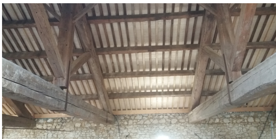
La charpente de la halle a fait l'objet d'un travail de rénovation minutieux, où seules les éléments abîmés ont été remplacés. photo ©CoCo architecture
