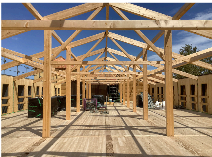
L'ensemble de la structure de l'extension est en bois : planchers, portiques, clos couvert. photo ©CoCo architecture
