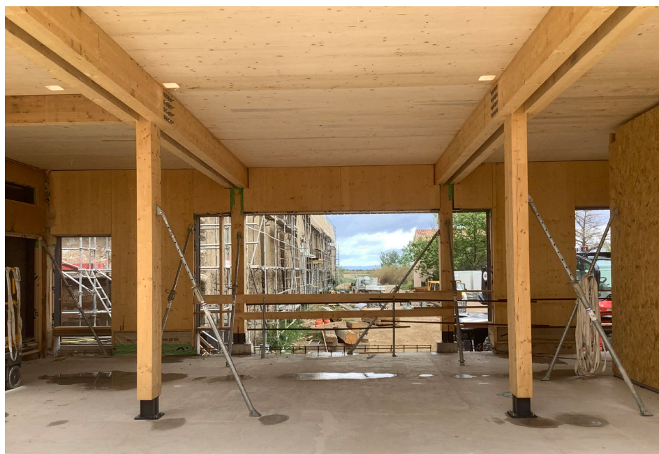
Structure en portique bois et plancher bois CLT. photo ©CoCo architecture
