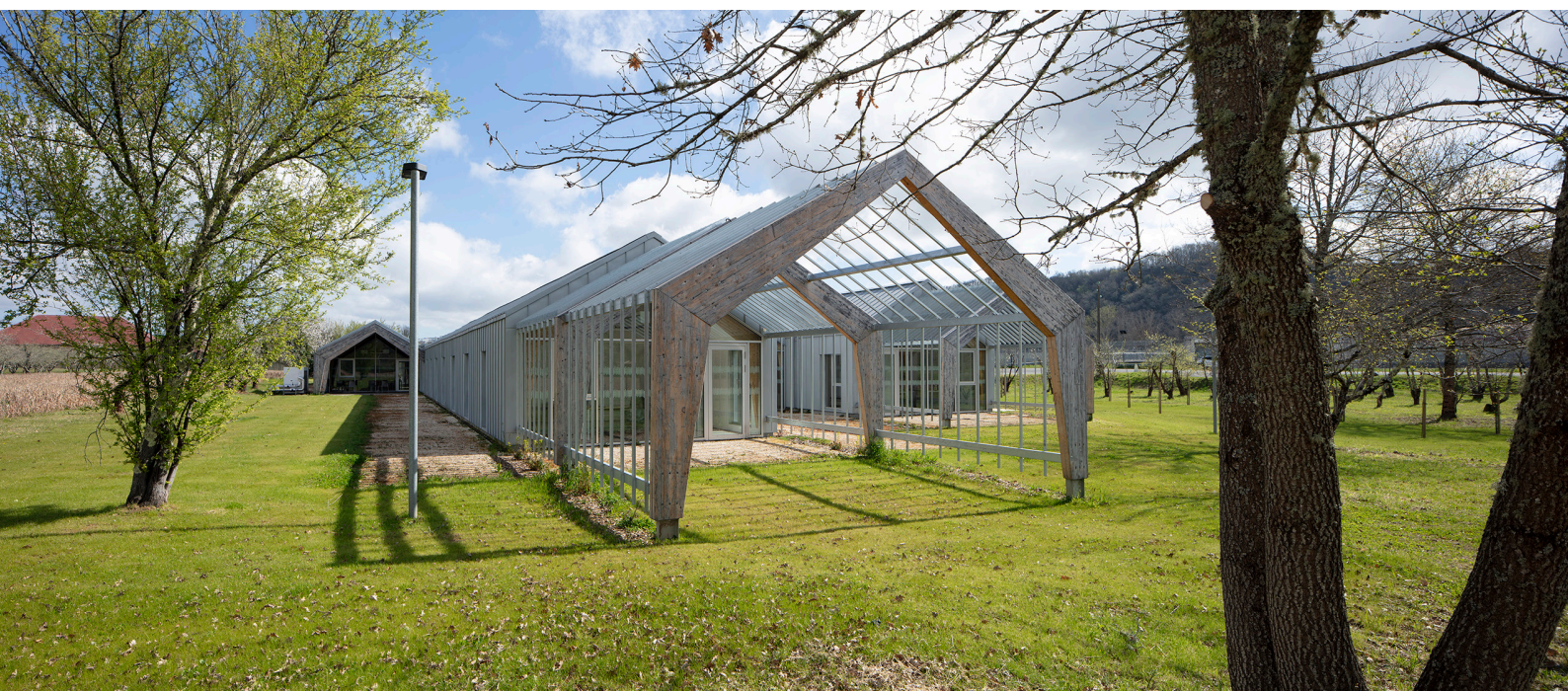
06 - Les portiques prolongent vers l'extérieur, permettant d'envisager une extension future s'appuyant sur des structures porteuses d'ores et déjà en place. photo ©Édouard Decam
