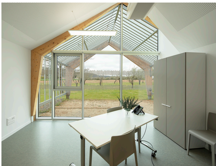
08 - Les portiques en bois de Douglas rythment l'espace, cadrent les vues et assurent une continuité visuelle fluide entre intérieur et extérieur. photo ©Édouard Decam
