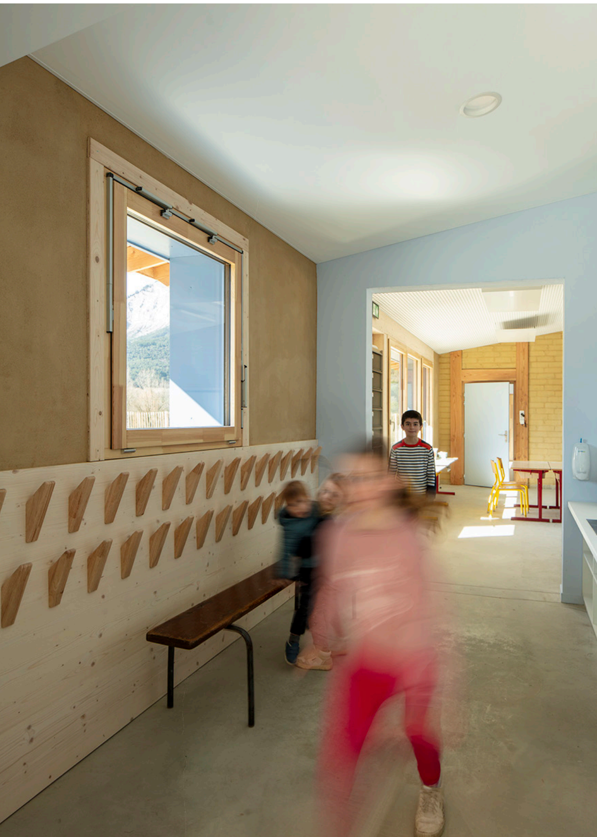
04 - Les finitions intérieures en enduit terre sur la paille participent au confort des occupants. photo ©Édouard Decam
