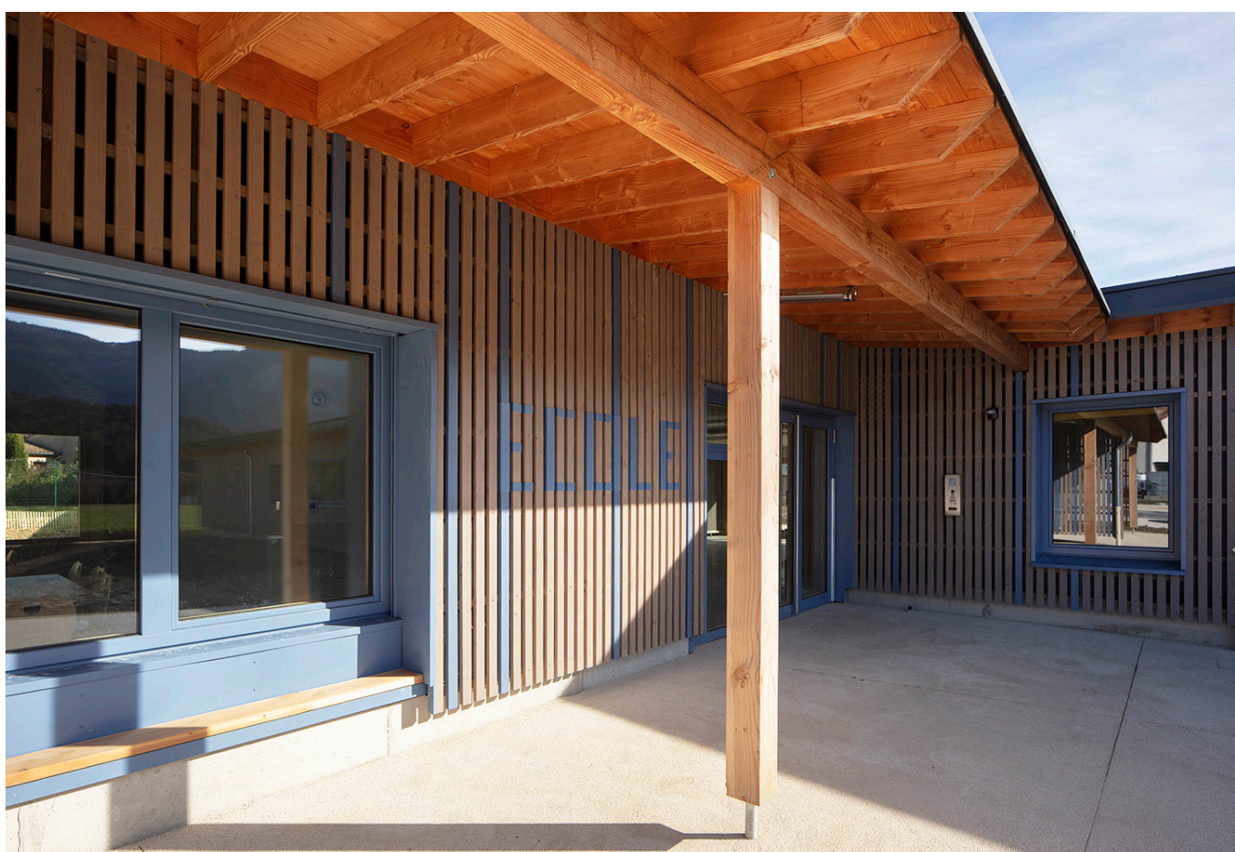
02 - Un auvent protège l'entrée et la façade de la cantine, accessible hors temps scolaire. photo ©Édouard Decam
