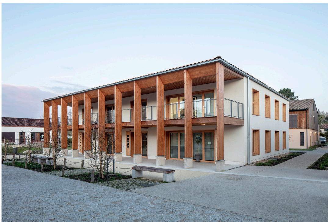
07 - Entre les terrasses et la halle, de nouveaux espaces de rencontres sont créés. photo ©Édouard Decam
