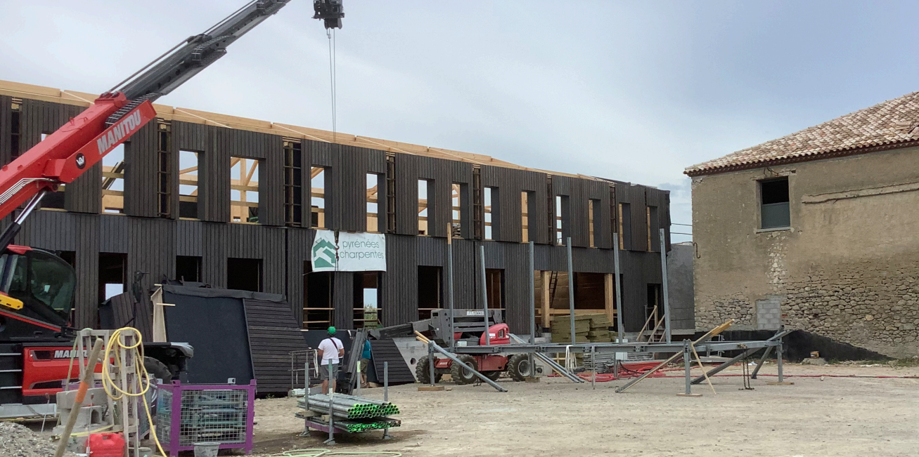
La façade, constituée de caissons préfabriqués isolés en laine de bois et bardés de bois brûlé, permet une mise en œuvre rapide sur le chantier. photo ©CoCo architecture
