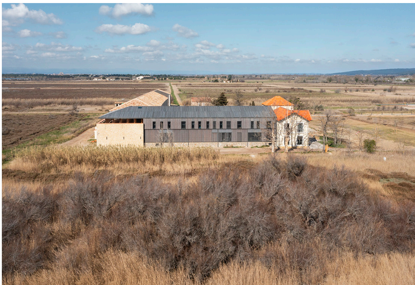
02 - Le Castelou, emblème du site, le bâtiment neuf, surélevé pour échapper aux inondations et la grande halle monumentale, témoin du travail de la vigne reconstituent un volume en L protecteur des vents dominants. photo ©Édouard Decam
