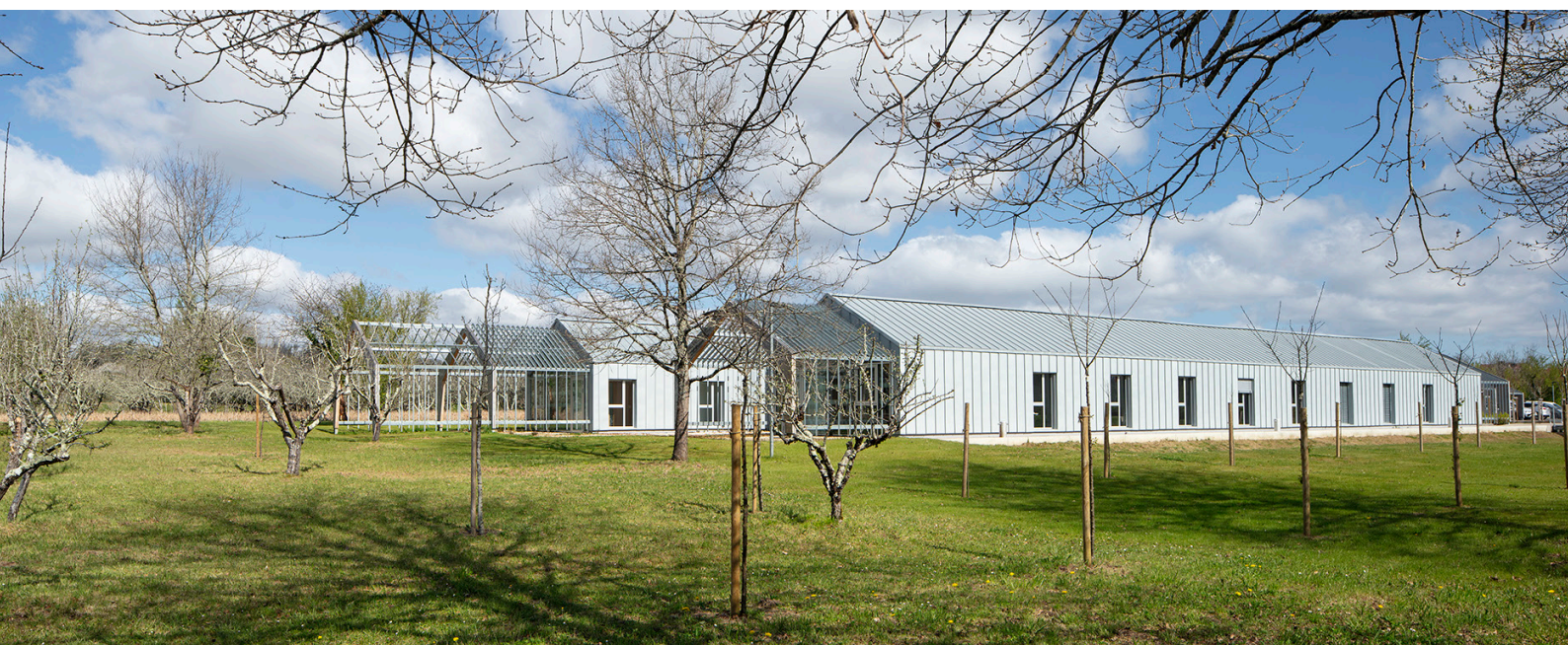
01 - Le bâti joue sur la trame agricole du site. photo ©Édouard Decam
