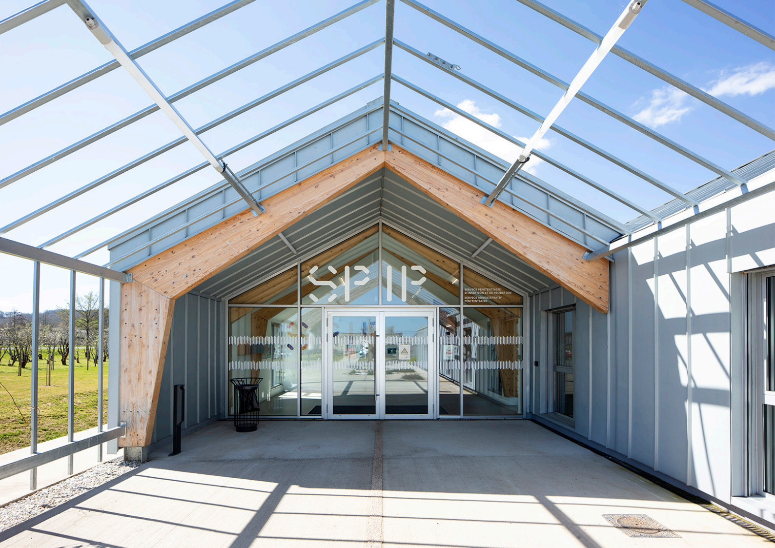
10 - L'entrée du bâtiment se distingue par le prolongement de la structure en un auvent généreux, affirmant le dialogue entre le bois et la peau de zinc. photo ©Édouard Decam
