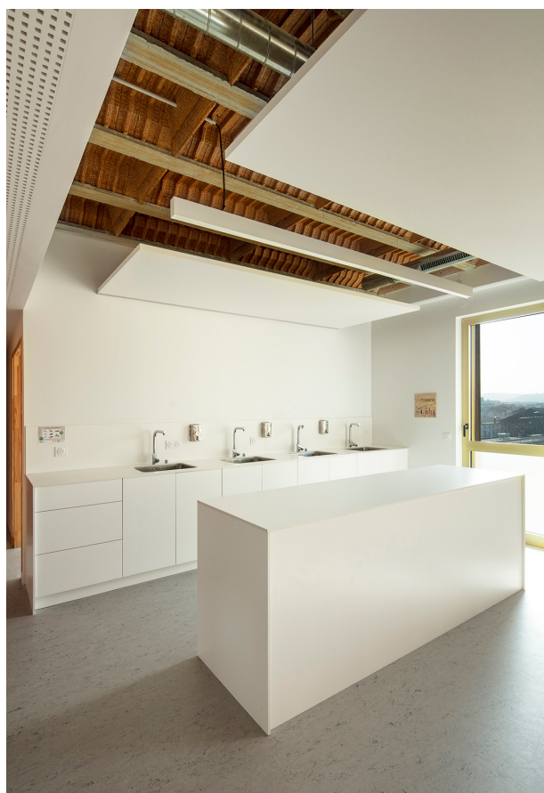
13 - Les planchers hourdis bois-béton sont laissés apparent au dernier étage, afin de donner à voir et à comprendre le système constructif de L'oustaL. photo ©Edouard Decam
