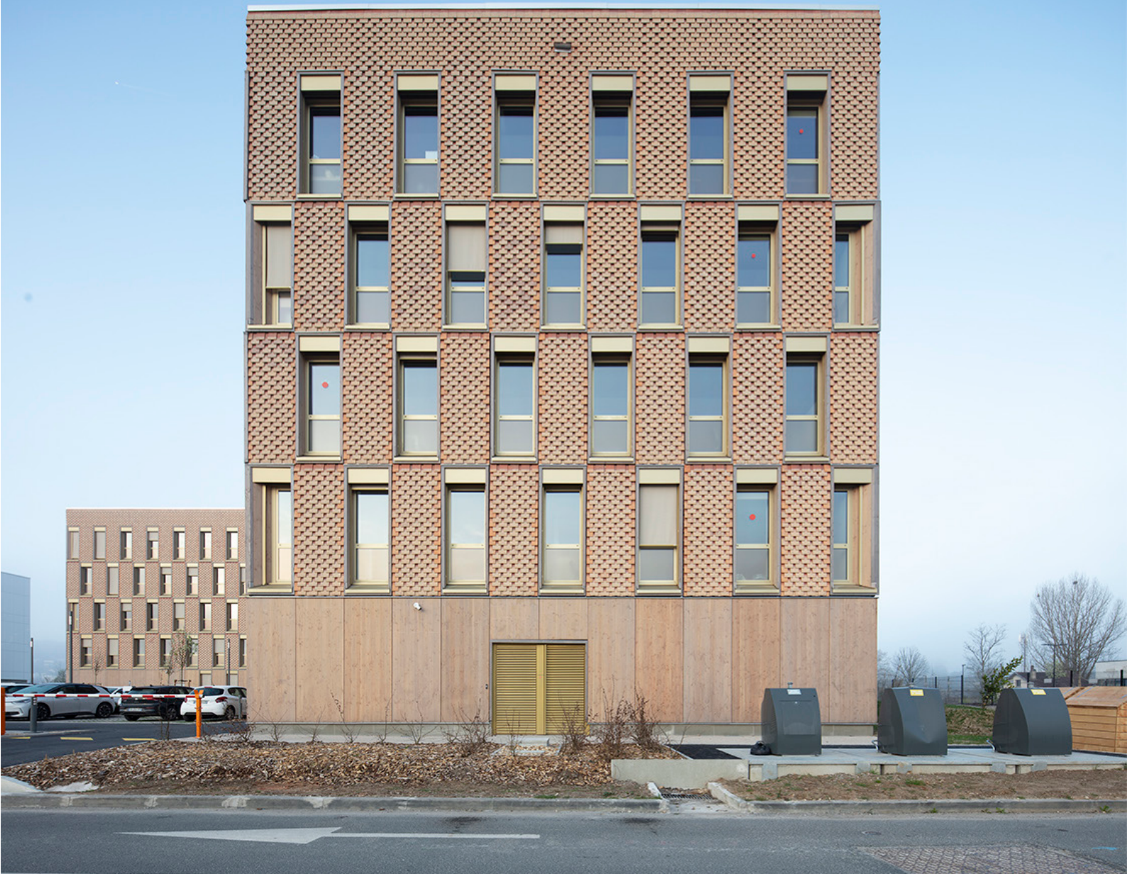
03 - Les percements des fenêtres répartis de manière régulière garantissent un apport de lumière naturelle suffisant et la modularité des plateaux de bureaux. photo ©Edouard Decam
