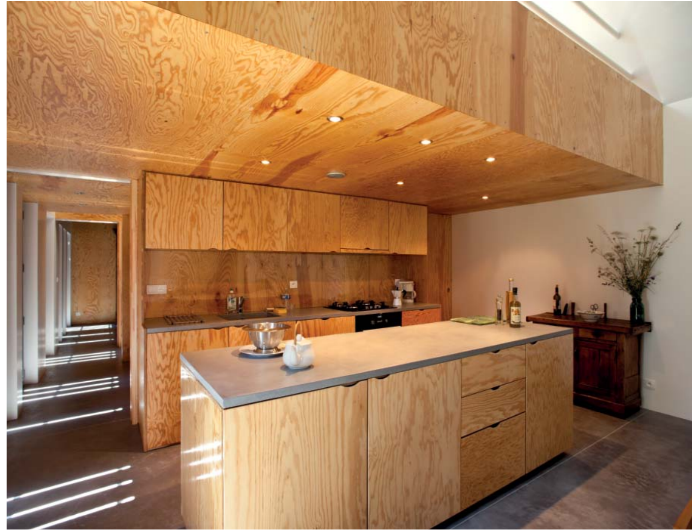
Sol. Le béton lissé est un revêtement de sol extrêmement résistant, nécessitant peu d'entretien dans le temps.
