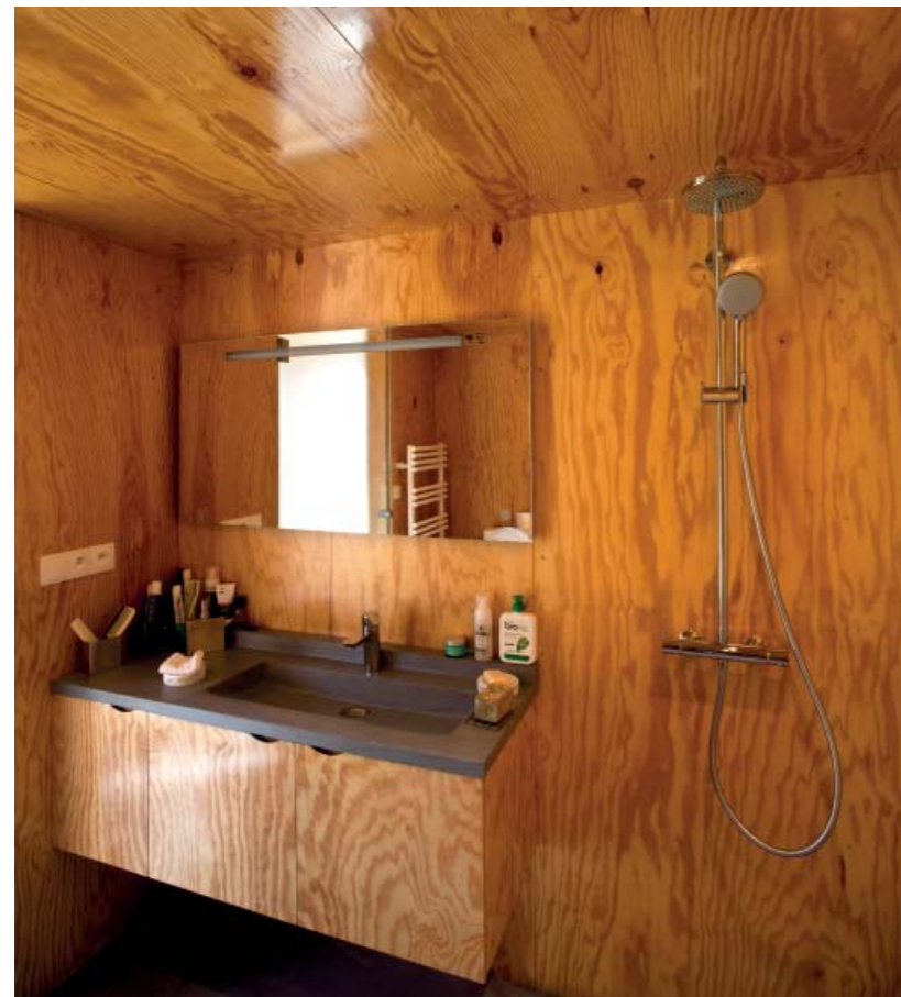
Contreplaqué. Les pièces humides, salle de bains, cuisine, sont réunies au centre de la maison par souci d'économie. En parement comme en placage, le contreplaqué CTBX est partout dans les pièces humides.
